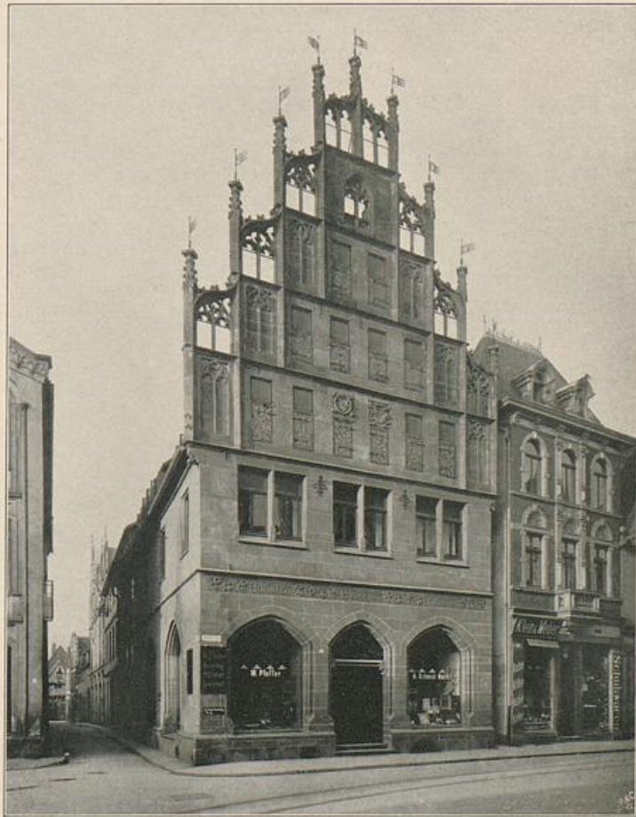
Abb. 103. Haus in der Oberntorstraße in Bielefeld. Nach einer Photographie von Ernst Lohhöfener in Bielefeld. (Zu Seite 114.)
