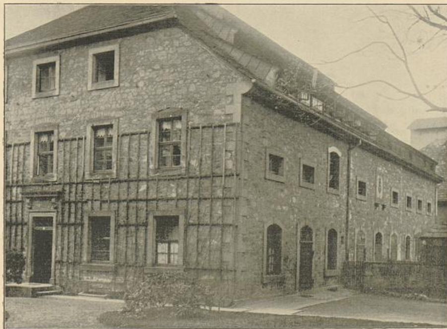
Abb. 102. Stallgebäude, Redenhof, Hameln.
