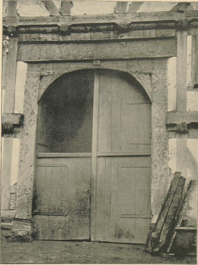
Abb. 119. Portal, Helmershausen, Steinstraße 16.
