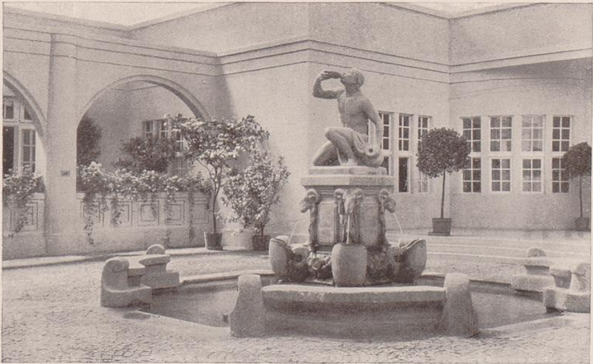
Lichthof in Halle I.
