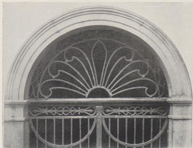
FRANKFURT a. M. OBERLICHT-GITTER AN DER LIEBFRAUENKIRCHE
