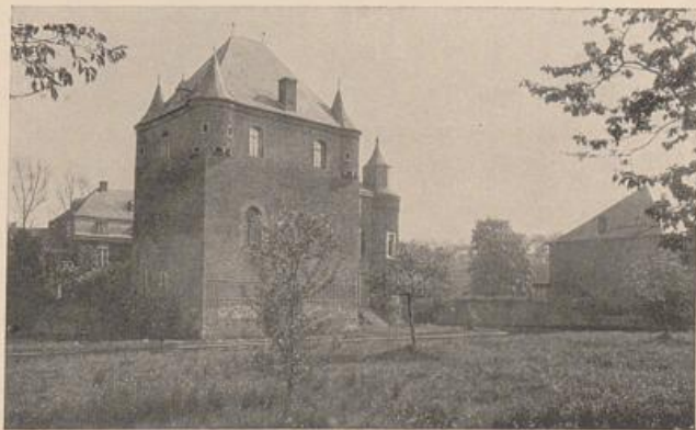
Abb. 121. Schloß Kellenberg. Das alte Burghaus. Vgl. Abb. 122 und 123.
