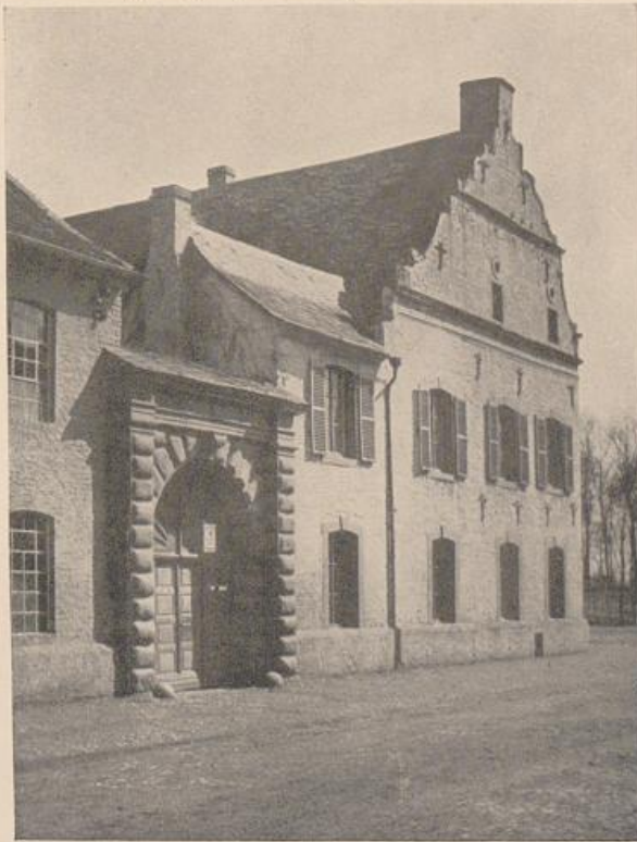
Abb. 112. Jülich. Das Setterichsches Haus.
