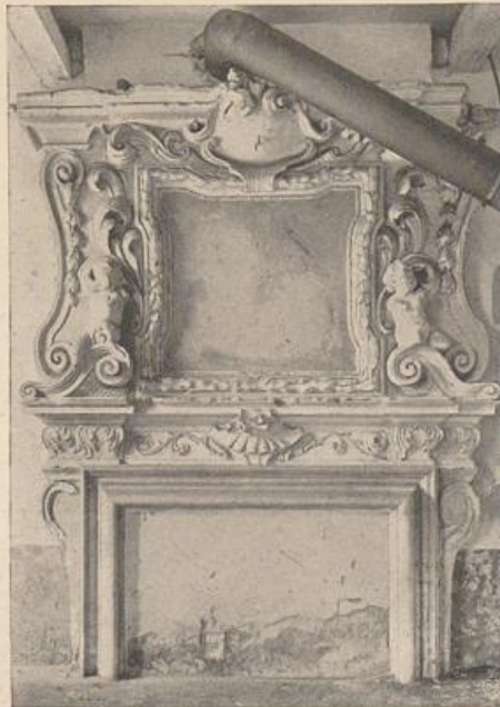
Abb. 344. Benrath. Orangerie. Kamin Aufnahme der Meßbildanstalt.
