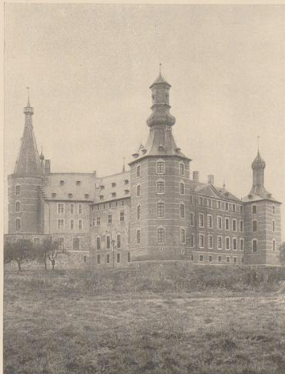
Abb. 311. Schloß Merode. Ansicht von Nordosten. Vgl. Abb. 308, 309.
