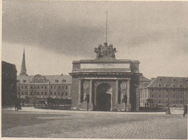
Abb. 336. Wesel. Berliner Tor. Feldseite. Heutiger Zustand. Vgl. Abb. 337, 338.
