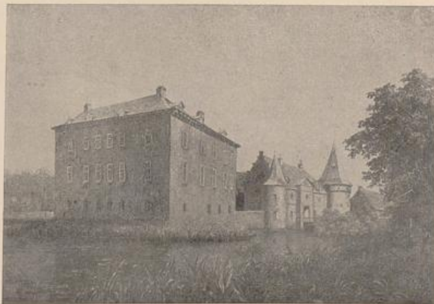
Abb. 126. Schloß Haag. Zustand vor der Restauration.
