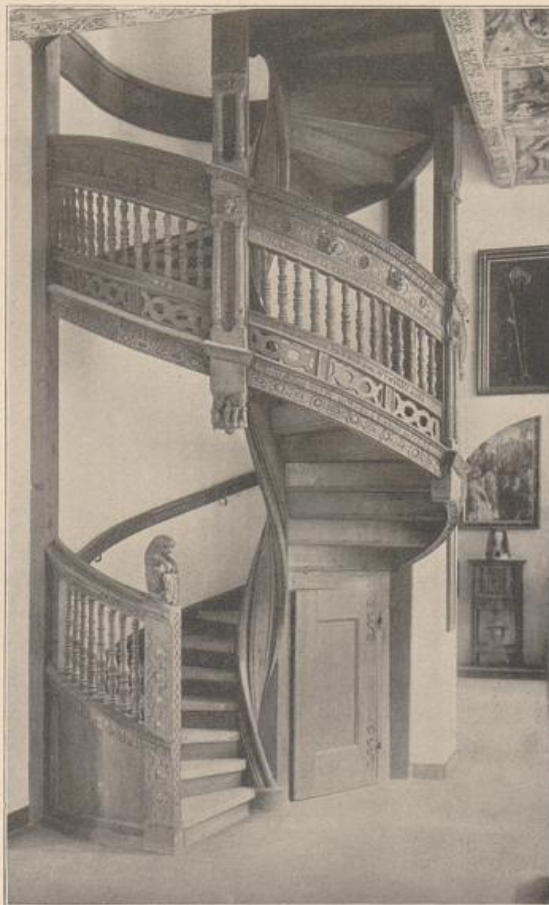
Abb. 271. Köln. Wendeltreppe aus dem Wasserfußchen Hause. Jetzt im Kunstgewerbe-Museum
