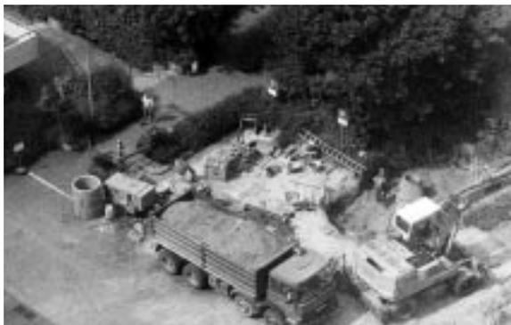
ungsmaßnahmen durchgeführt. Die Abwasseranlagen auf dem Campus sind zuvor mittels Kanalfernüberwachung überprüft und der Zustand der Leitungen auf Video dokumentiert worden. Betroffen von den notwendigen Sanierungsmaßnahmen waren u.a. Kanalhaltungen in verschiedenen Parkplatzbereichen (Nähe Bauteil N, Gebäude H, Mensa-Anlieferung (Foto), Bibliothek) sowie im Innenhofbereich (parallel zu Bauteil B) und im Bereich der Sportanlagen.
