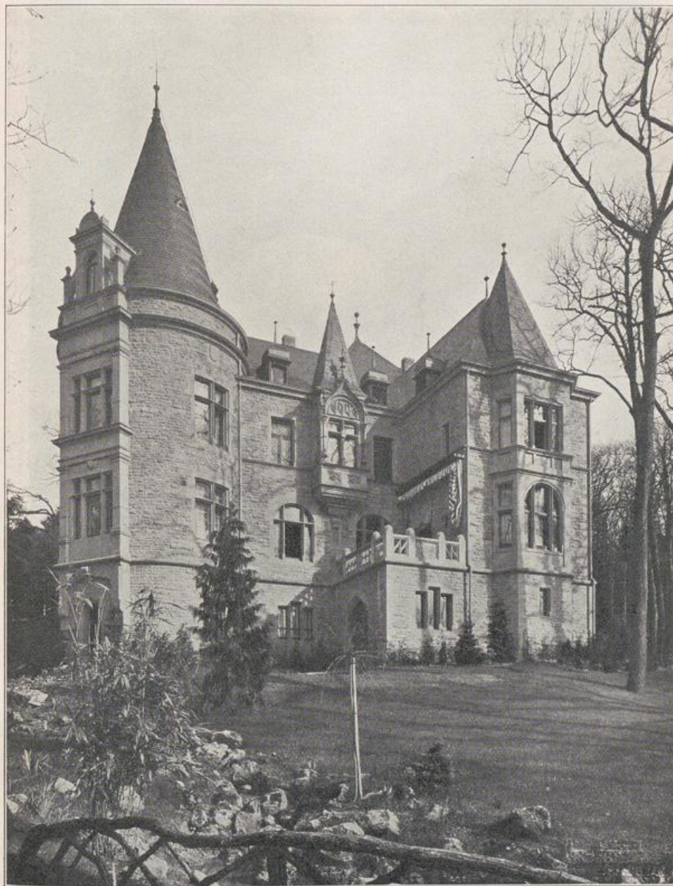
Abb. 119. Ansicht des Schloßchens der Gräfin Allcard-Konarska. Architekt: Dr. J. DURM.
