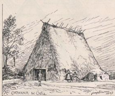
Abb. 21. Ansicht einer Capanna bei Ostia.
