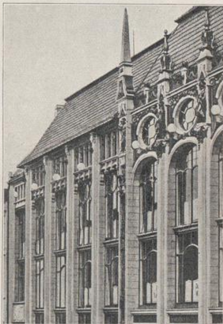
Abb. 90. Warenhaus Wertheim in Berlin. Architekt: MESSEL.
