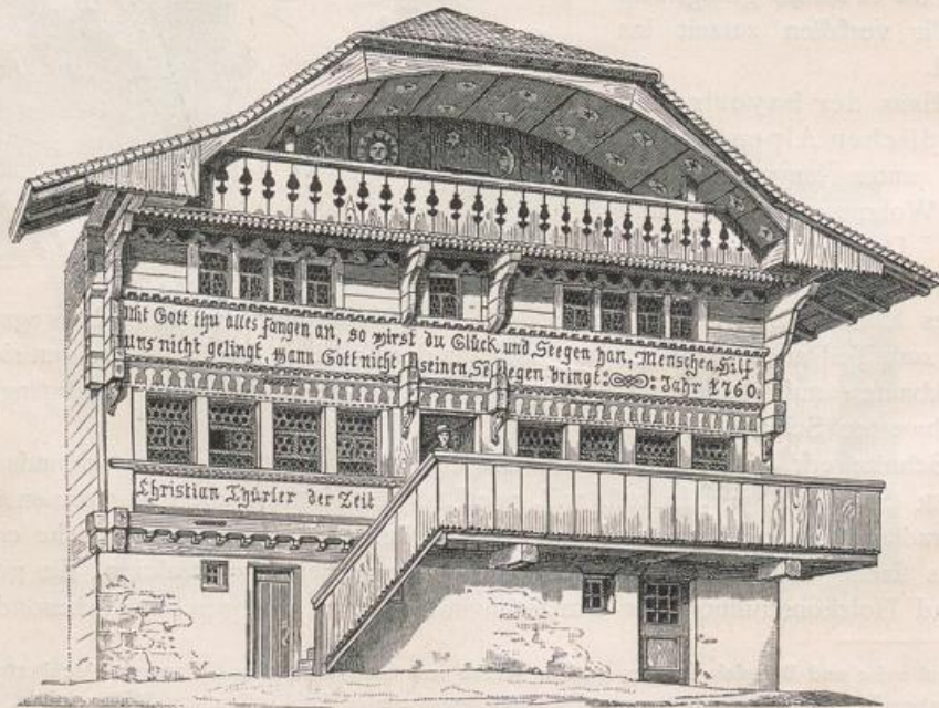
Abb. 32. Kombiniertes Block- und Ständerbau.
