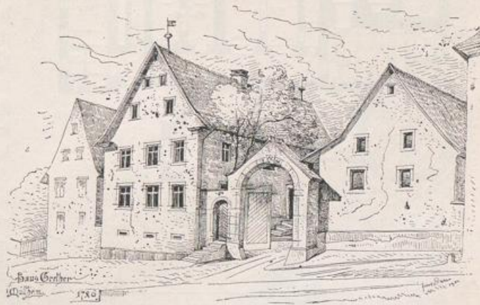
Abb. 116. Herrenhaus Grether mit Torweg und Scheune in Müllheim bei Badenweiler.
