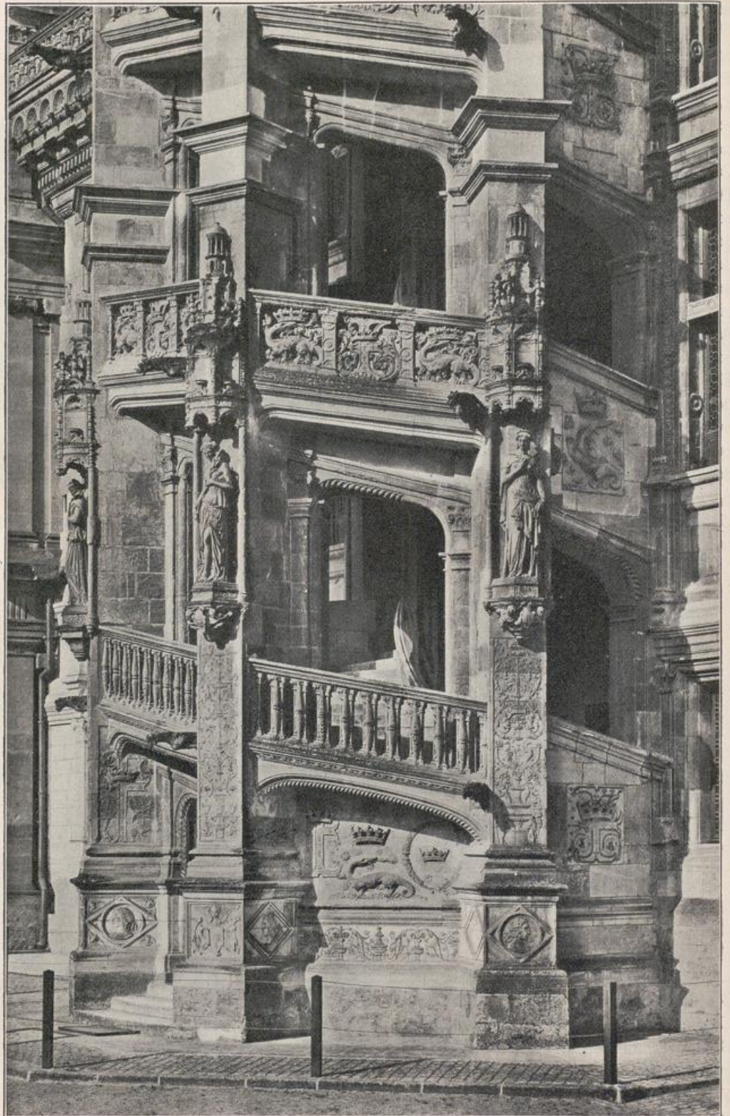
Abb. 158. Treppe aus dem Schloß zu Blois.
