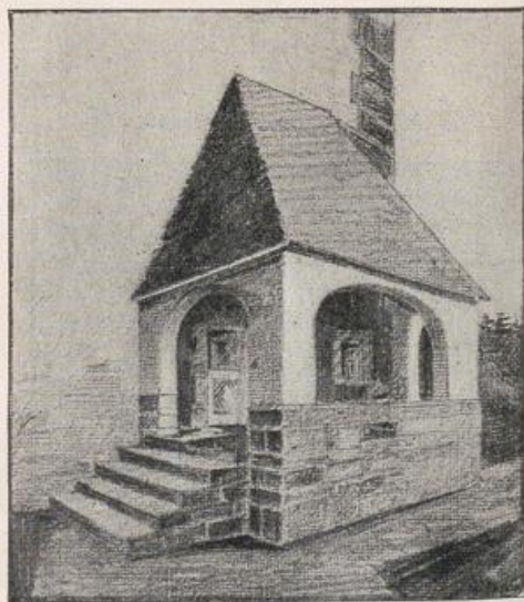
Abb. 102. Hauseingang mit im Freien liegender Treppe.
