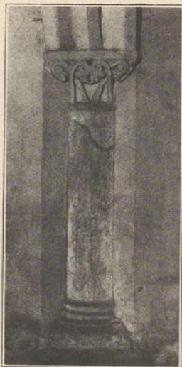
Abb. 24 Achteckige Säule in der Trennungswand zwischen Krypta und Grabgewölbe.
