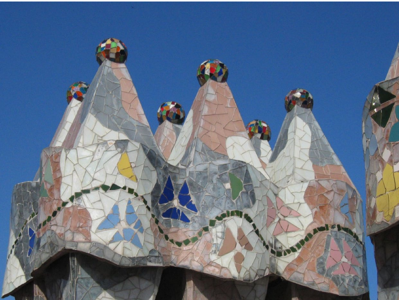
Abb. 2 Kamine auf der Dachterrasse der Casa Batlló
