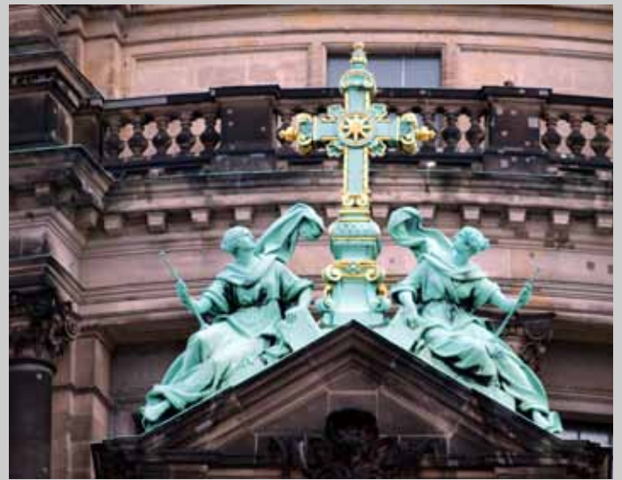
Abb. 10 Bronzefiguren bestehen aus einer Kupfer-Zinn-Legierung und werden im Laufe des Alterungsprozesses von einer Patina bedeckt.
