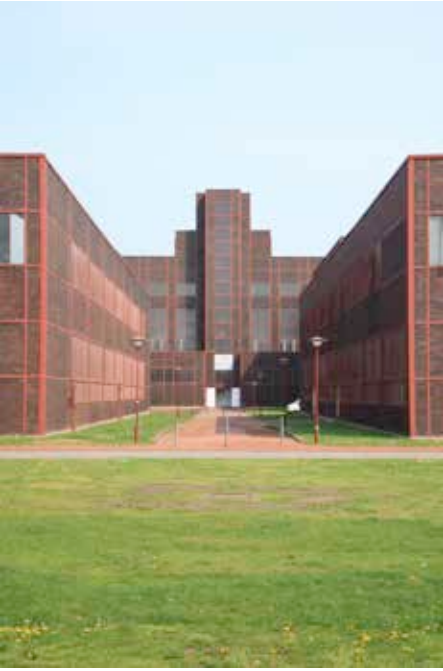
Abb. 6 Blick auf das Kesselhaus
