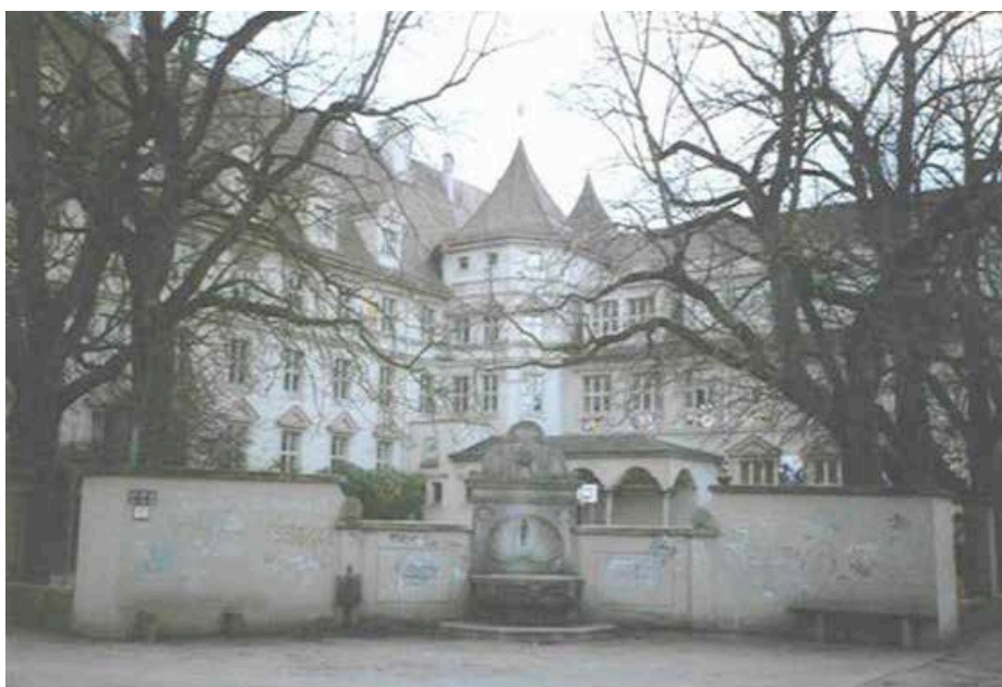
Augsburg, Adlhoch-Schule Außenbrunnen
