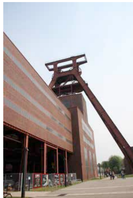
Abb. 5 Fördergerüst und Schachthalle
