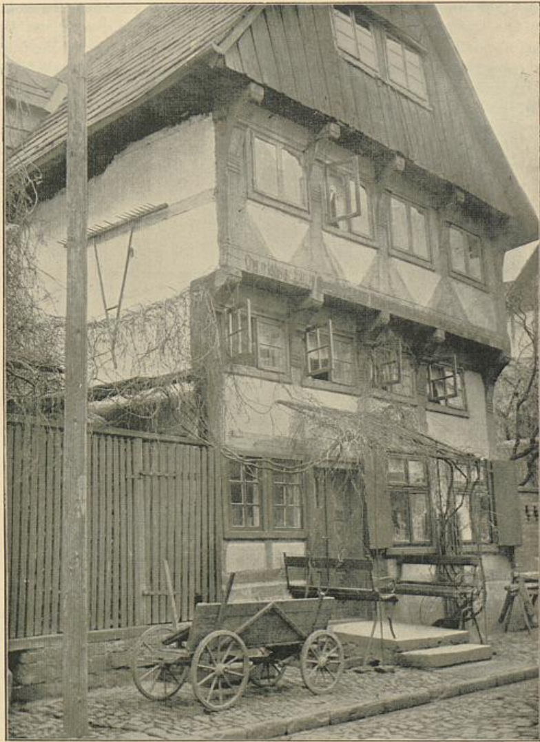
Abb. 95. Bodenwerder, Kleinstaße 224, erbaut 1530.
