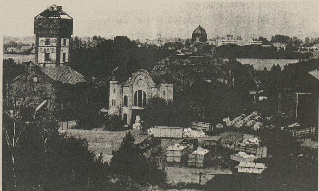
Verkommt: das ehemalige Zechenhaus (Mitte) auf dem Stadthäger Georgschachtgelände.
