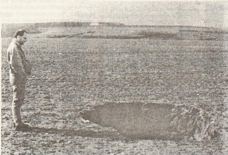
Einer der neuen Erdfälle der Paderborner Hochfläche.
