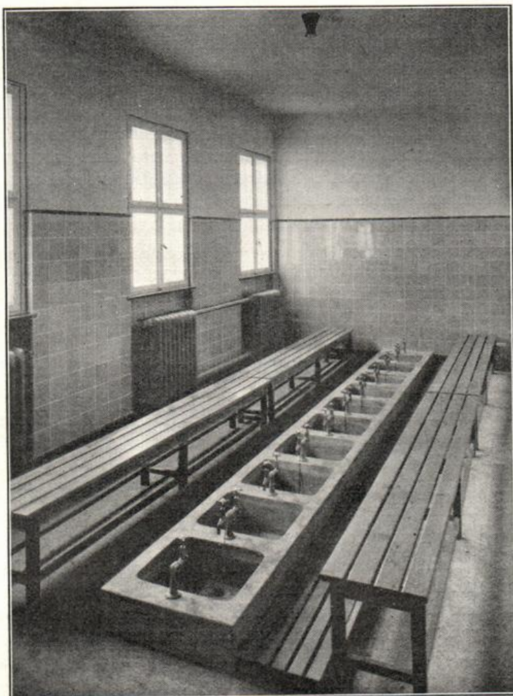
Fußwaschraum an der Turnhalle.
