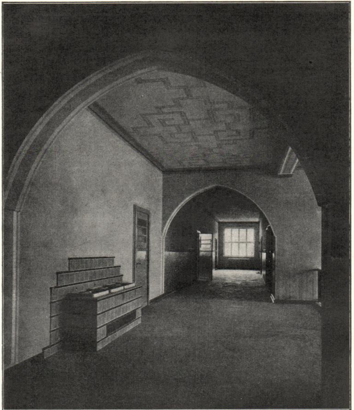
Volksschule in Hermsdorf: Flur.
