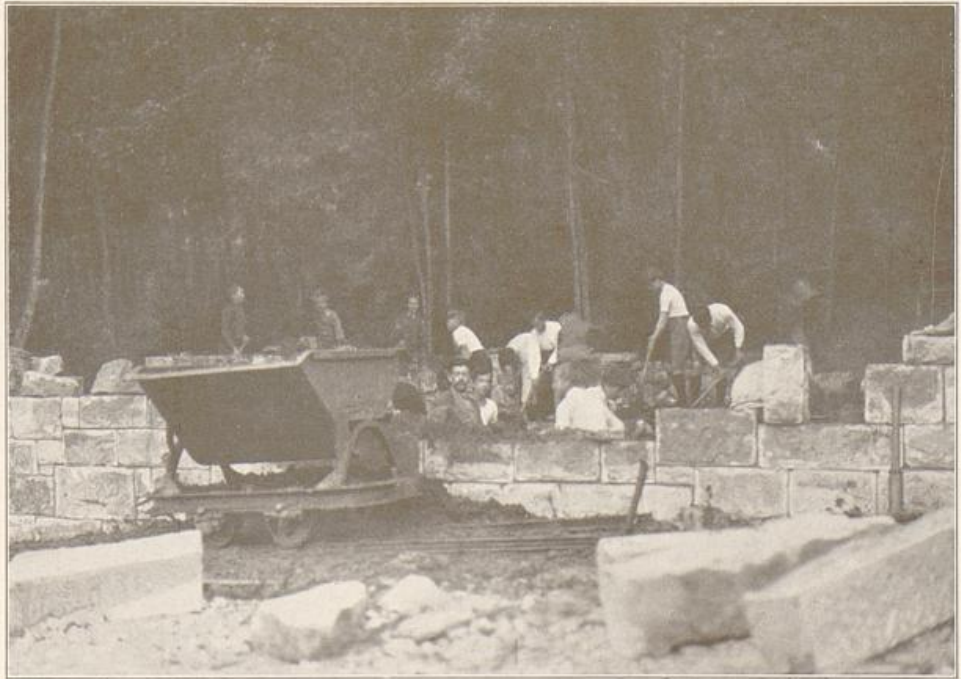
Bau der Grundmauern für Haus Emilia
