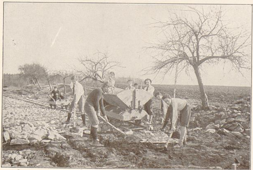
Bei der Erdarbeit
