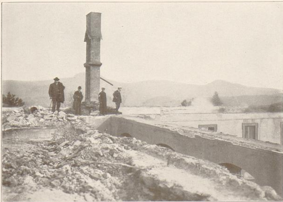
Ein Kamin im Dachgefchoß
