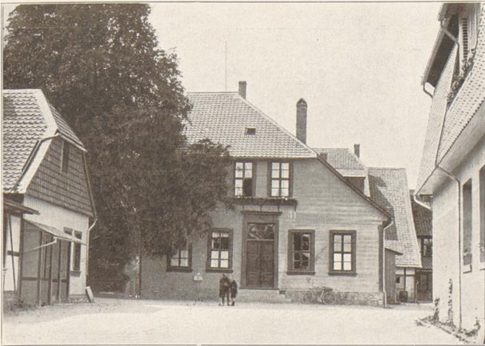
Die alten Wohnhäuser
