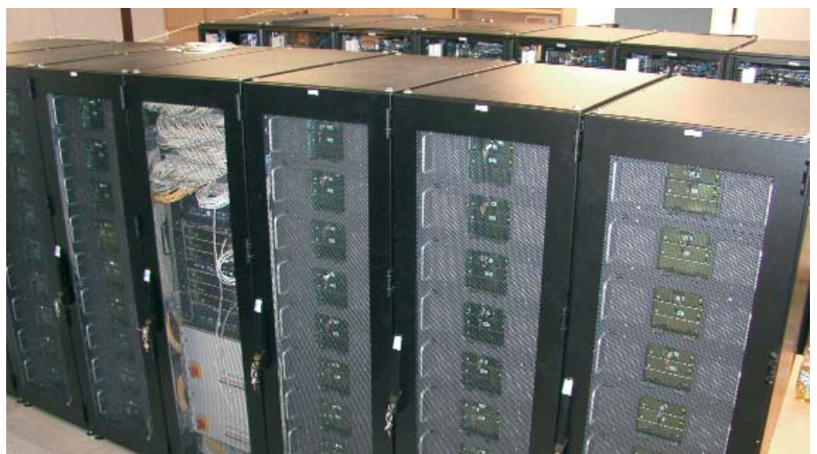
Der aktuelle Hochleistungsrechner des PC 2 wird auf der 25. Liste der weltweiten TOP 500 Supercomputer auf Platz 205 geführt.
