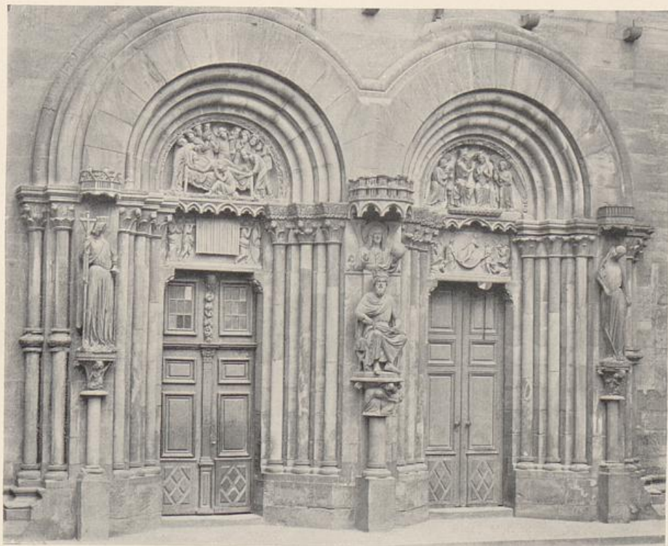
155. Südostportal des Straßburger Münsters (gegenwärtiger Zustand)
