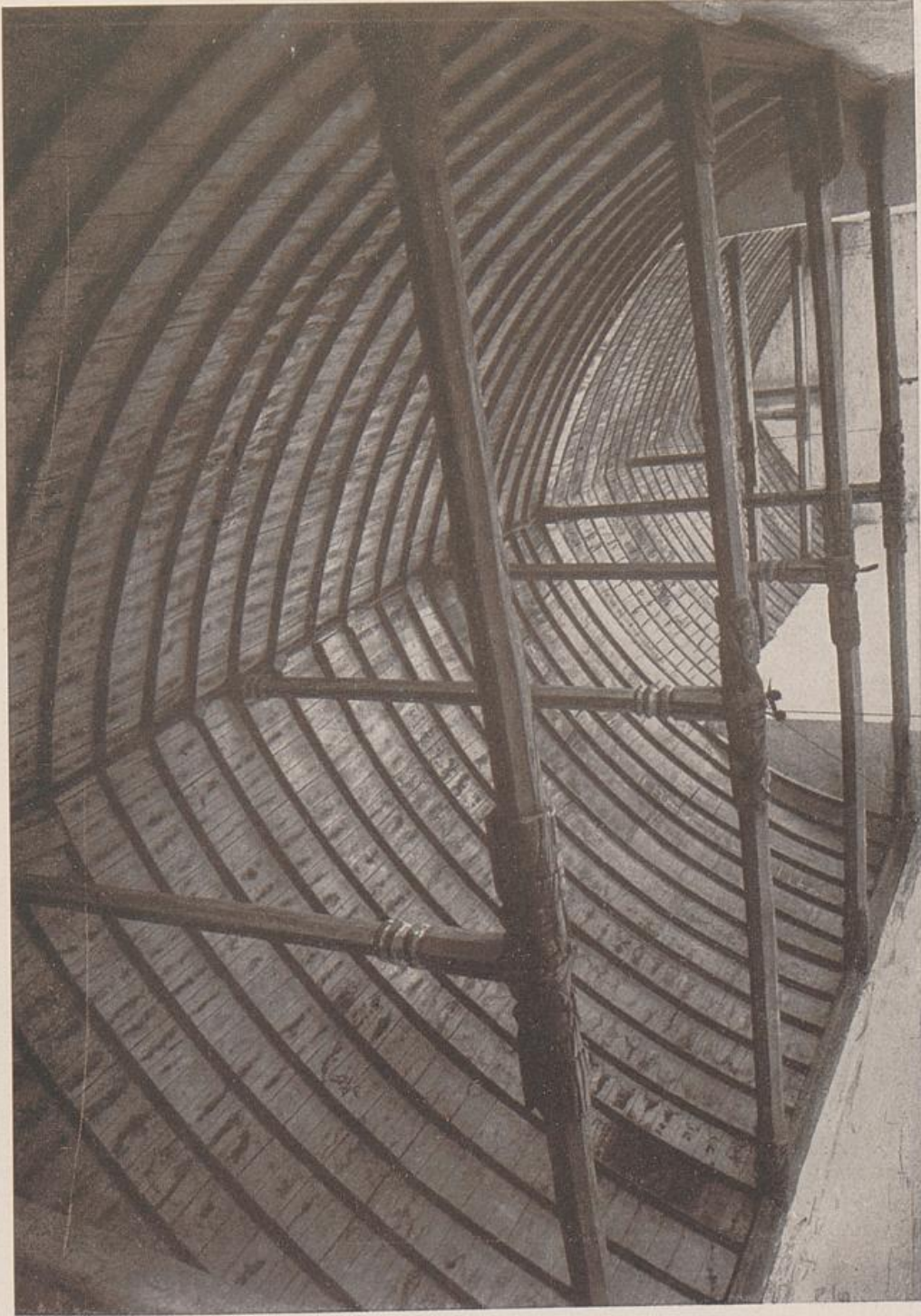
61. Selomes, gewölbte Decke der Kirche, Holz
