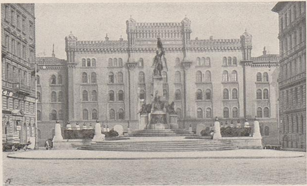
Das Denkmal des Regimentes Hoch- und Deutschmeister von dem Bildhauer J. Benk und dem Architekten A. Weber (1906). Ansicht vom Schottenring aus. Im Hintergrunde die Rudolfskaserne.
