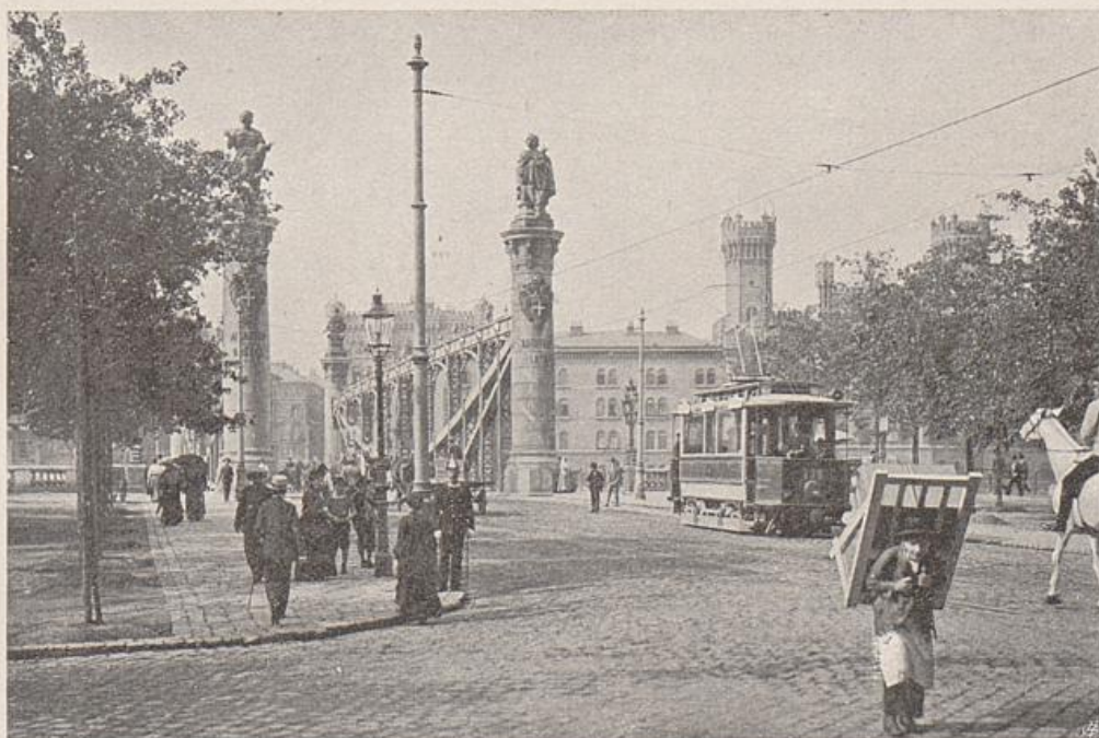
Die Augartenbrücke über den Donaukanal (1873). Von der Leopoldstadt aus gesehen.
