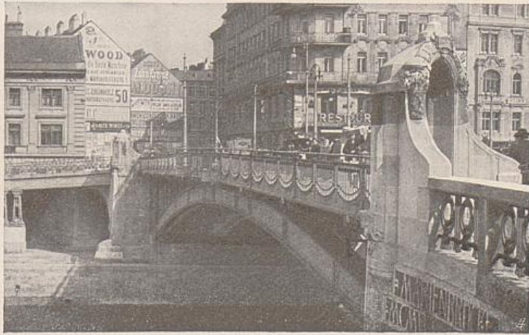
Die Marienbrücke in der Richtung gegen die Leopold- stadt zu gesehen.
