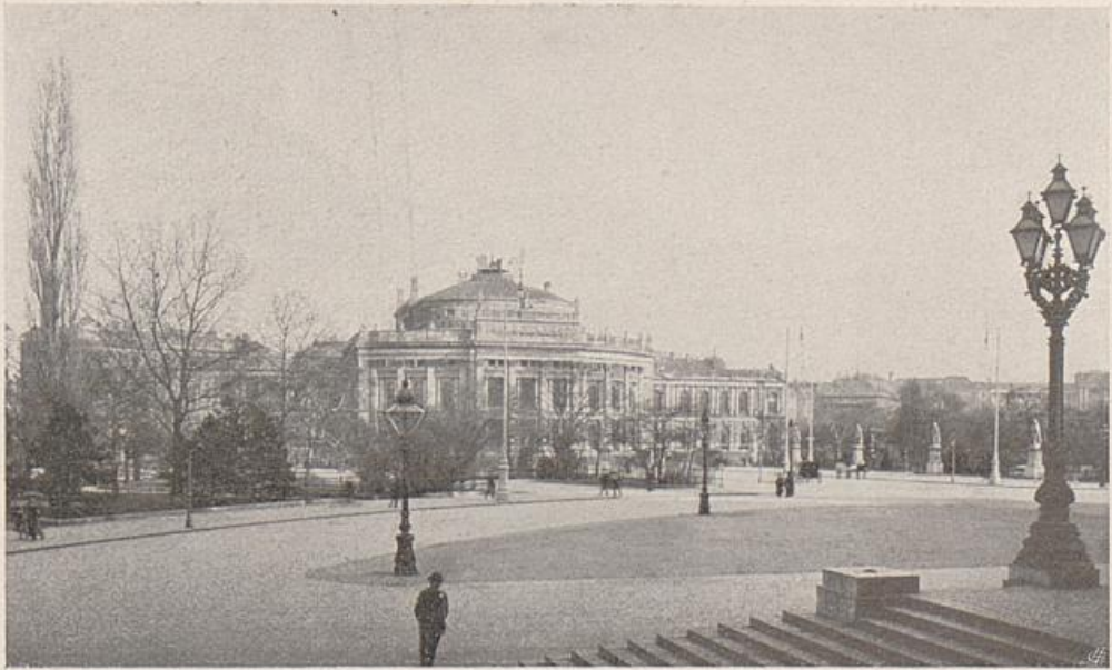
Das k. k. Hofburgtheater, erbaut von Semper und Hasenauer (1880—1886). Von der Treppe des Rathauses aus gesehen.
