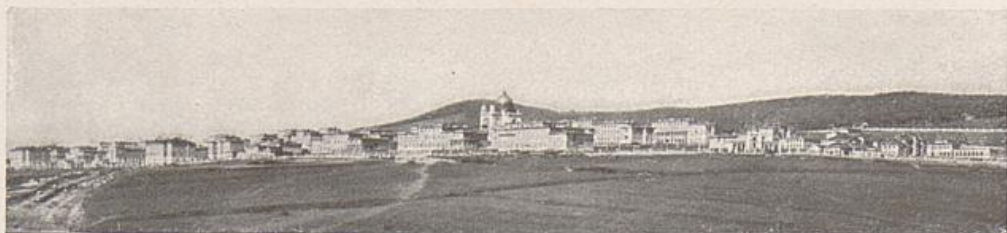
Gesamtansicht der im Jahre 1907 eröffneten Niederösterreichischen Landes-Heil- und -Pflege- anstalten „Am Steinhof“ auf dem Abhange des Galizinberges.
