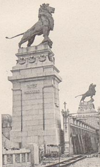
Die Schleuse des Donaukanals beim Ruzhdorfer Spitz.
