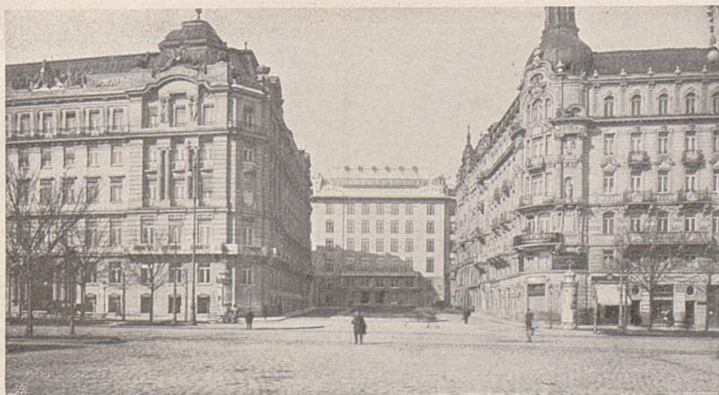
Blick in die Pfalzstraße vom Stubenring aus. Im Hintergrunde das Gebäude der Postsparkasse, erbaut von O. Wagner (1907). Links die Handels- und Gewerbekammer, erbaut von L. Baumann.
