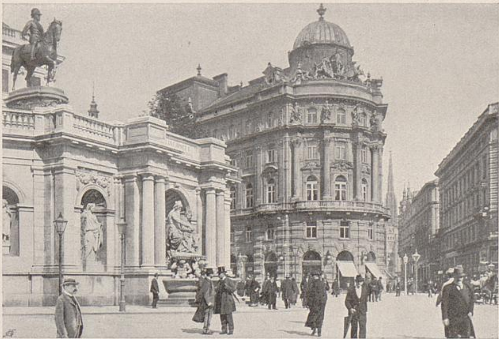
Der Albrechtsplatz mit dem Albrechtsbrunnen, darüber das Denkmal des Erzherzogs Albrecht von Zumbusch (1898). Im Hintergrunde der Stephansturm.
