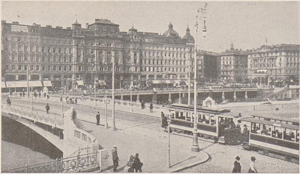
Die Marienbrücke, erbaut 1906 von J. Hackhofer, mit Blick auf den Franz-Josefs-Kai und die Galerien der Stadtbahn.
