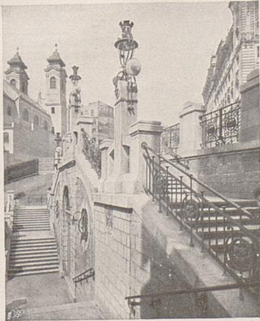
Die neue Stiege zwischen der Fillgrader- und Theobaldgasse.
