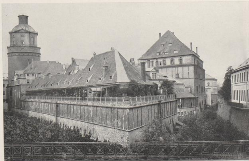
LEIPZIG • DIE PLEISZENBURG (wegen des neu erbauten Rathauses abgetragen. Der um 1800 als Sternwarte ausgebaute Turm ist in veränderter Form erhalten).
