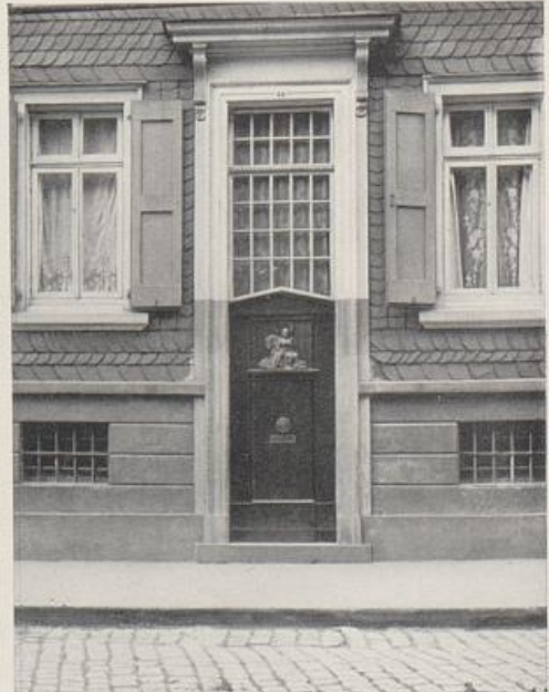
ELBERFELD CASINOSTRASZE 32 (um 1825) (Tür nach Beseitigung der Freitreppe heruntergerückt)
