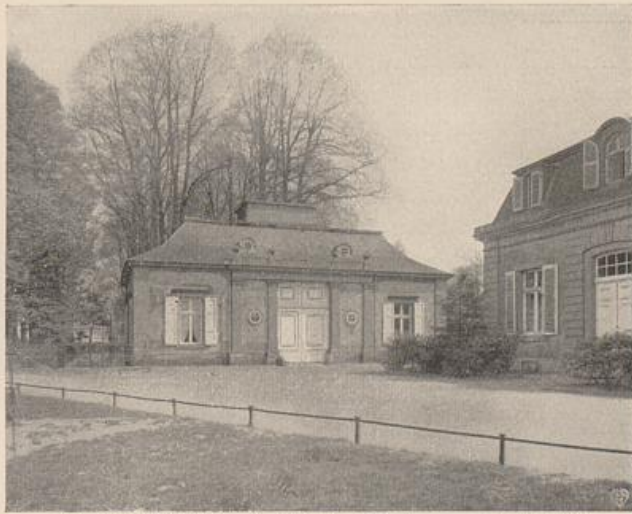
Abb. 167. Schloß Benrath. Seitliche Außenbauten. Vgl. Abb. 168.
