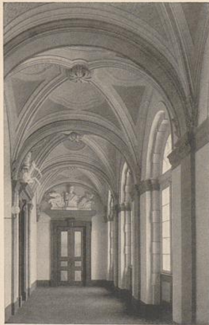
Abb. 36. Schloß Bensberg; Korridor des südlichen Seitenflügels. Vgl. Abb. 35
