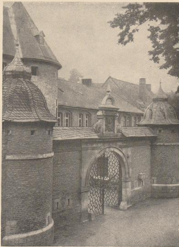
Abb. 68. Cornelimünster. Außentorbau der Abtei vom Jahre 1682. Vgl. Abb. 72.
