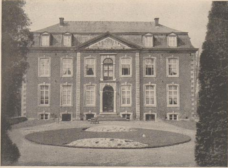
Abb. 174. Cortenbach. Neues Herrenhaus. Vgl. Untergebäude, I. Abb. 318.
