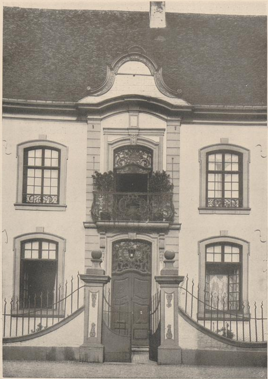
Abb. 173. Heinsberg. Mittelstück des ehemaligen Prämonstratenserklosters. Vgl. Abb. 172.
