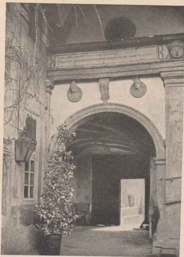
Abb. 176. Schloß Rheydt. Einfahrt in den Hof des Herrenhauses.
