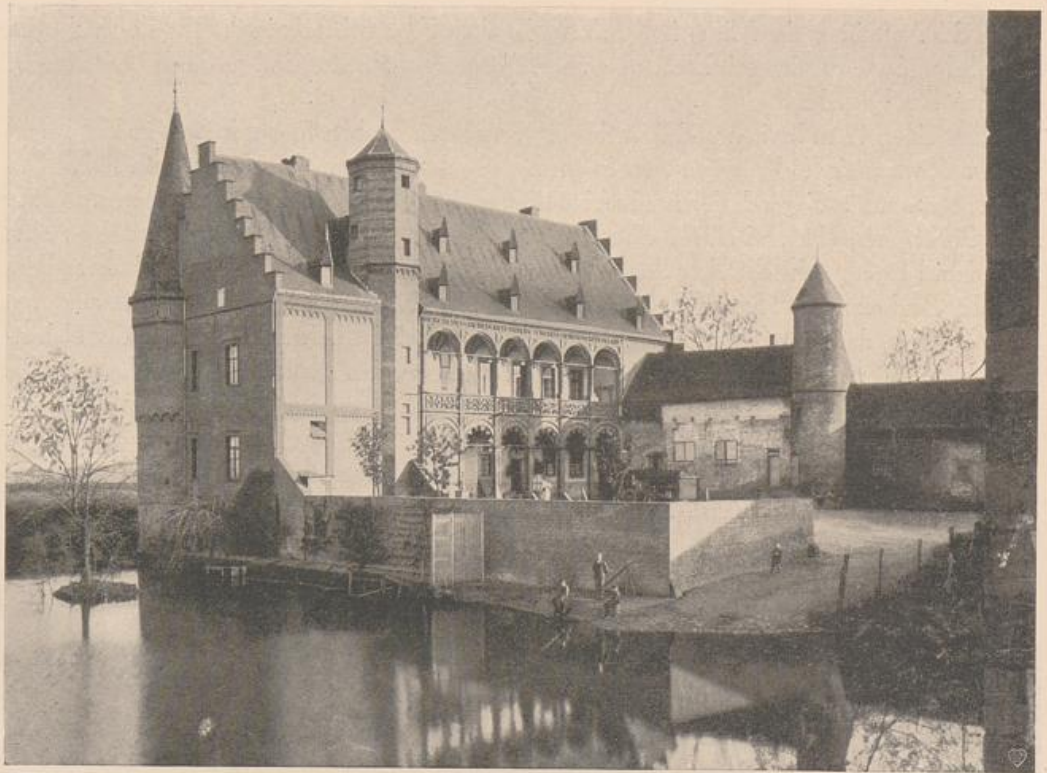
Abb. 172. Binsfelder_Burg. Vgl. Abb. 173.
