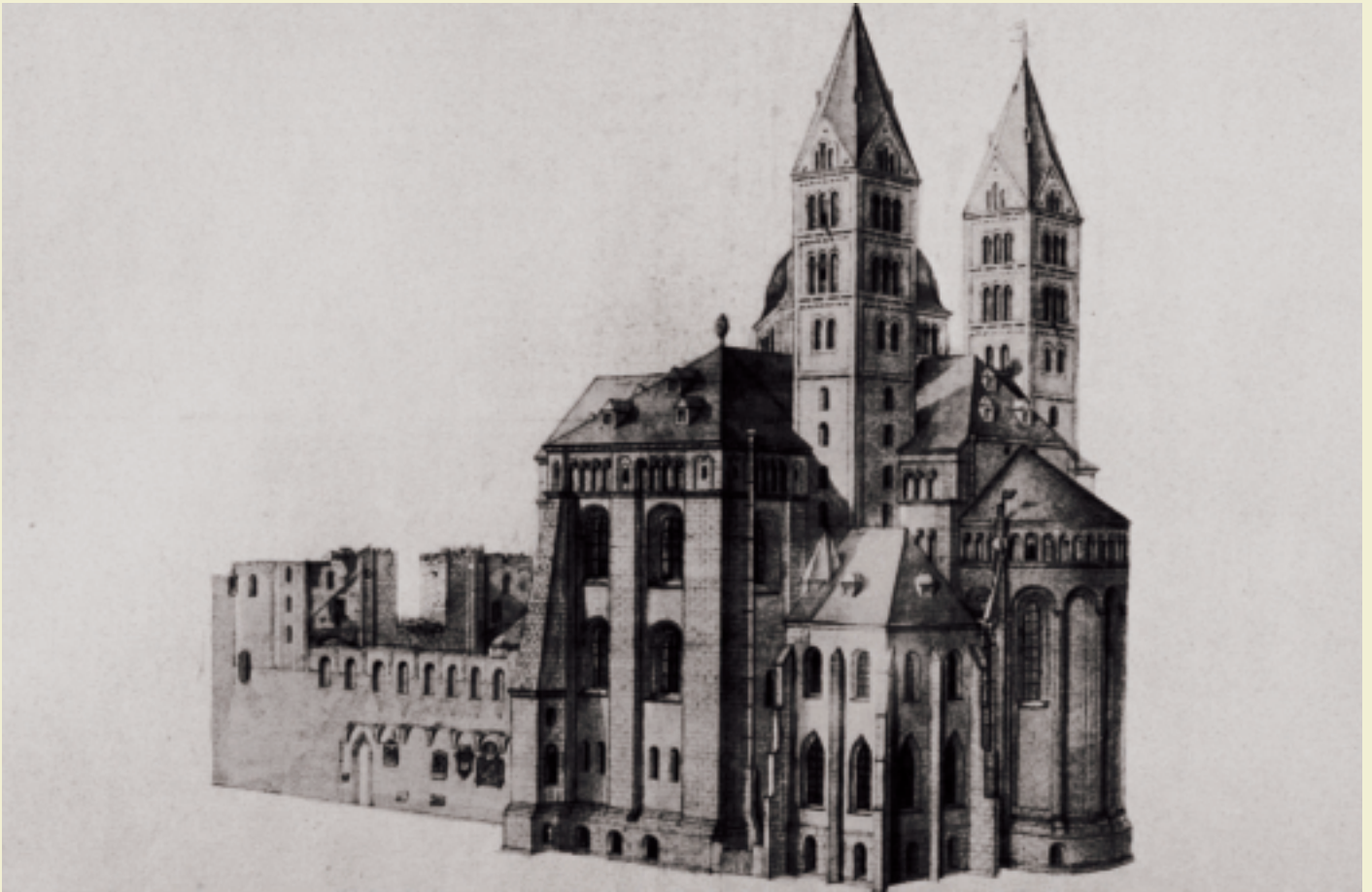
Der Dom zu Speyer von Südosten, während des Abbruchs des Westwerks, mit den 1689 zerstörten westlichen Teilen des Langhauses und zur Hälfte abgebrochenen Westwerks, BS 3037, lavierte Federzeichnung (um 1755/56). [3]
