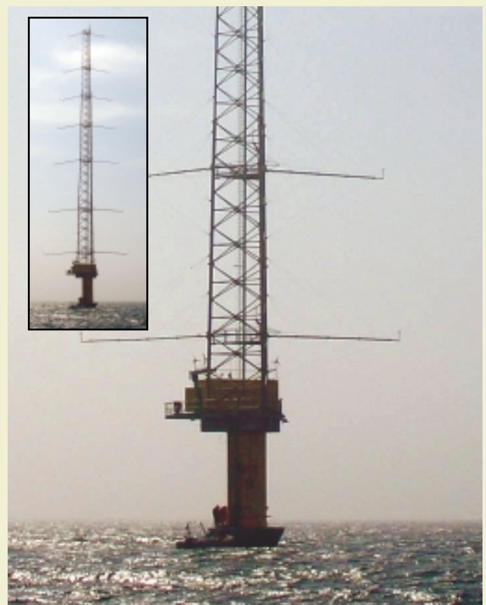
Abb. 2: Messmast Arkonabecken Südost.
