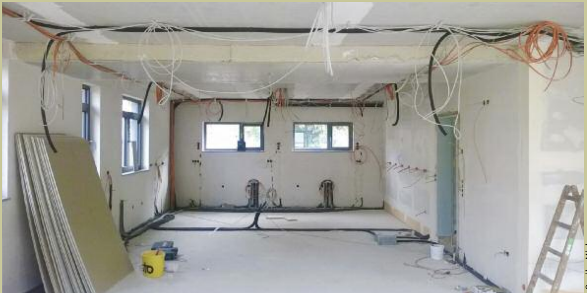
Abb. 3: Wohnung Rohbau. Blick in den Rohbau einer vernetzten Wohnung eines Projektpartners von KogniHome. Die zu sehenden Kabel dienen ausschließlich der Kommunikation.
