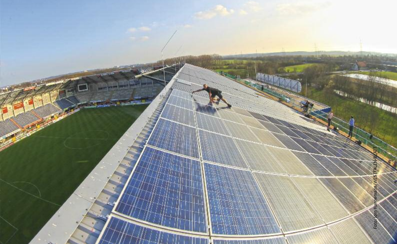
Abb. 1: Strom aus Dachanlagen. Die 4 570 Quadratmeter große Photovoltaikanlage auf dem Dach der Benteler-Arena in Paderborn kann mit bis zu 600 Megawattstunden den jährlichen Elektroenergieverbrauch von fast zweihundert Haushalten decken. Viele dieser Anlagen könnten zukünftig durch noch effizientere ersetzt werden.
