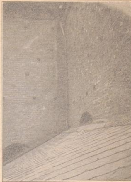
b. Ecke zwischen Chor und Nordtransept.
