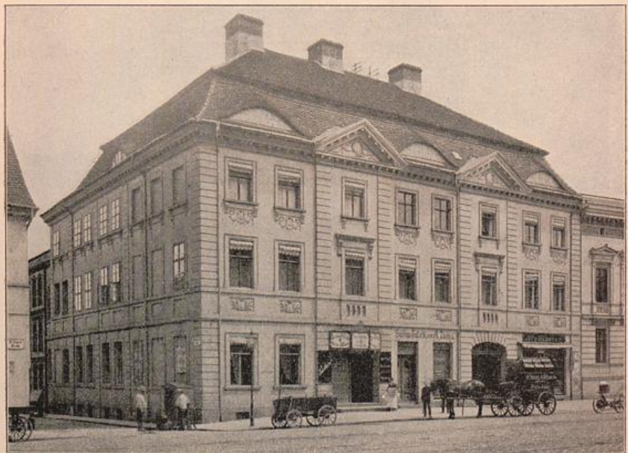
Abb. 129. Haus Bieten, St. Annenstraße 12.
