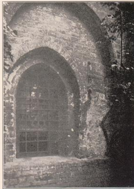
d. Kryptafenster mit romanischem Mauerrest rechts.
