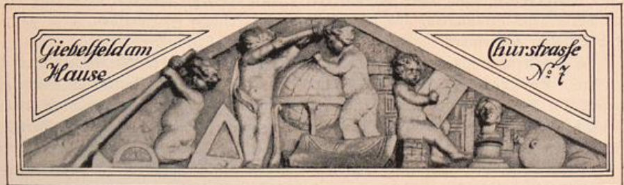
Abb. 126. Giebsfeld am Hause Kurstraße 7.
