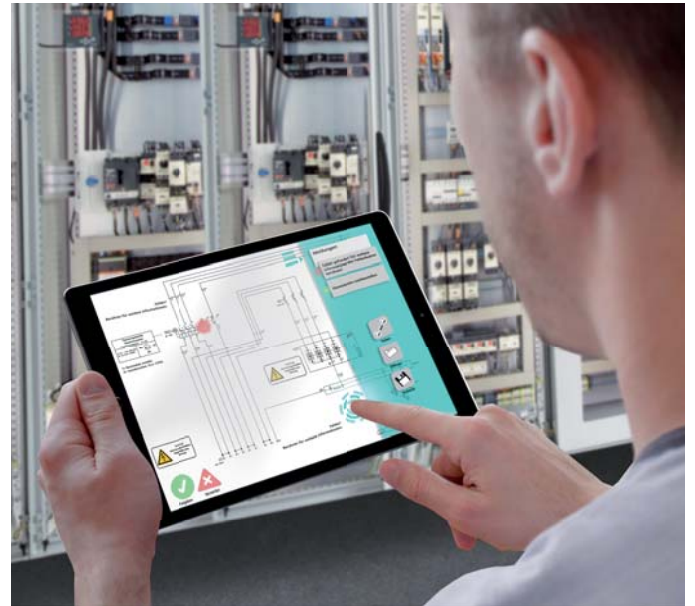
„Digitalisierung im Schaltschrankbau“ ist ein Projekt im Kompetenzzentrum „Digital in NRW“
