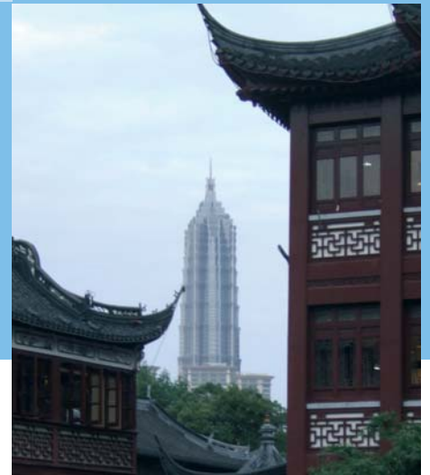
Boomtown Shanghai: Blick von der historischen Altstadt auf den 421m hohen Jin-Mao-Tower
