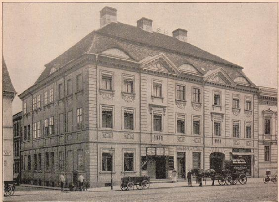
Abb. 129. Haus Bieten, St. Annenstraße 12.
