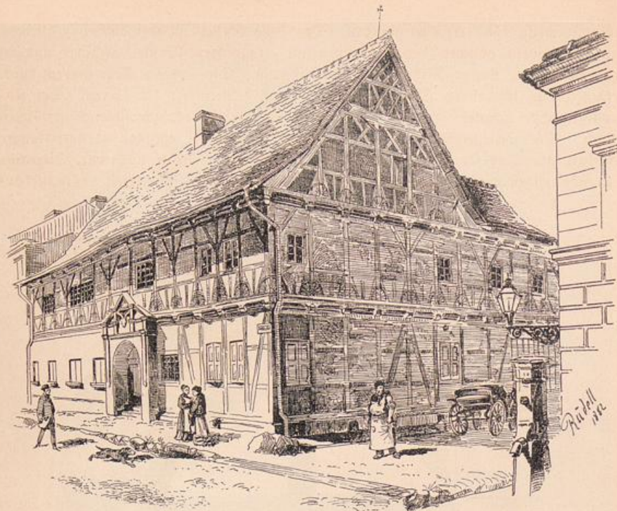
Abb. 120. Haus Bäckerstraße 11 in seinem früheren Zustande (nach Bergau, Fig. 81).
