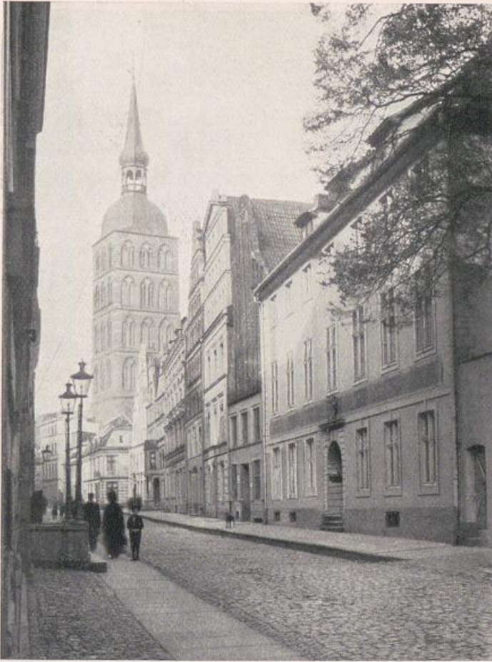
80. Stralsund: Badenstraße, Turm St. Nikolai
