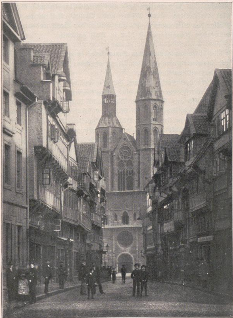
97. Braunschweig, Hagen: Katharinenkirche und Hagenbrücke
