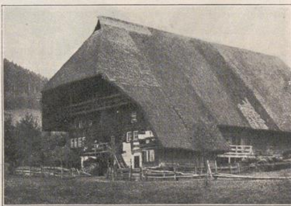
Abb. 26 16) . Ansicht von einem Schwarzwaldhaus.
