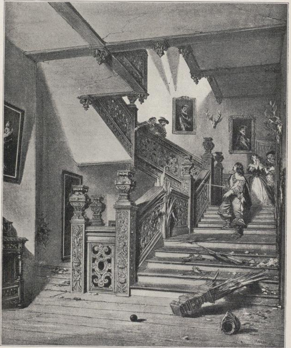
Abb. 164. Englische Holztreppe (Aston-Hall).
