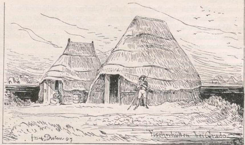
seitlichen Dachflächen und 4,20 m hoher First. Die Konstruktion des Daches besteht aus drei Bindern, die aus zwei durch 2 Brustriegel verbundene Streben aus 8 cm dickem Rundholz zusammengesetzt sind, und eine runde Firstpfette und zwei rechteckige Dachpfetten aufnehmen, auf die
