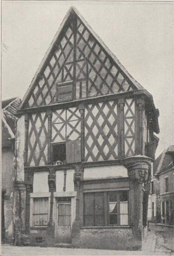
dessen Schnitt in Abb. 43 wiedergegeben ist, nach dem die Überkragungen der Stockwerke zusammen von der Sohle bis zum Obergeschoß 2,50 m betragen!
