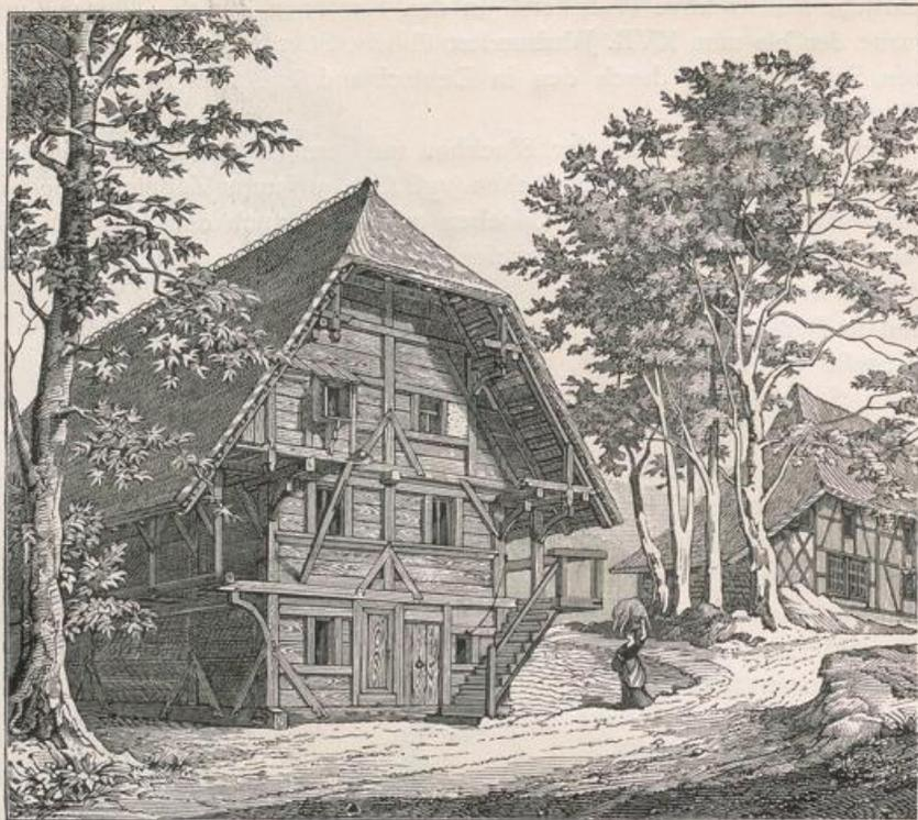
Abb. 32. Kombiniertes Block- und Ständerbau.
