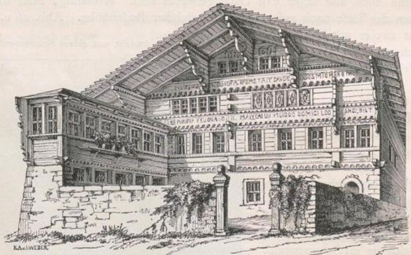
und Blockfassaden gelten, das 1760 erbaute Haus in Jaun (vgl. Abb. 32) als ein solches mit kombiniertem Block- und Ständerbau und bogenförmig abgeschaltem Dachvorsprung,
