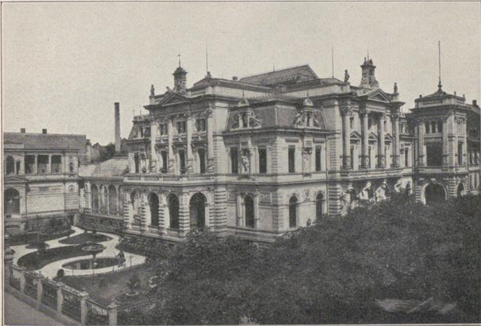
Abb. 98. Haus Schmieder in Karlsruhe. Architekt JOS. DURM.
